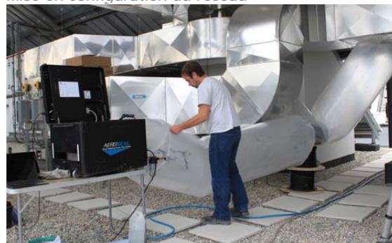
Insufflation de la résine via une gaine souple et visualisation en direct du taux de fuite
